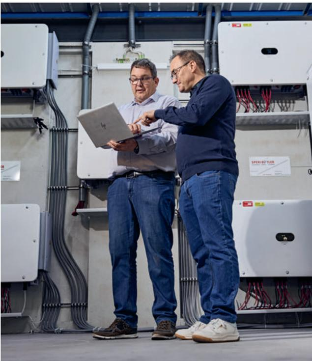
Mit fünf Huawei Wechselrichtern werden die 733 kWp in AC-Netzspannung umgewandelt.
