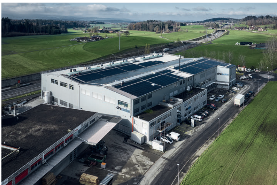
1733 moduli solari coprono il tetto della sede centrale di Dresohn AG a Mettmenstetten, Zurigo.
